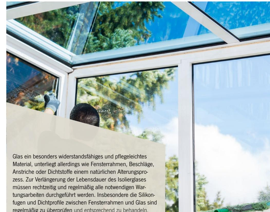
Glas ein besonders widerstandsfähiges und pflegeleichtes Material, unterliegt allerdings wie Fensterrahmen, Beschläge, Anstriche oder Dichtstoffe einem natürlichen Alterungsprozess. Zur Verlängerung der Lebensdauer des Isolierglases müssen rechtzeitig und regelmäßig alle notwendigen Wartungsarbeiten durchgeführt werden. Insbesondere die Silikonfugen und Dichtprofile zwischen Fensterrahmen und Glas sind regelmäßig zu überprüfen und entsprechend zu behandeln.
